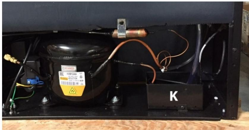
Puede eliminar el agua de condensación del recipiente colector de condensación con una bayeta de cocina. El colector se encuentra en la parte inferior derecha del panel trasero del aparato. Cuando termine, vuelva a enroscar la cubierta de metal de forma que quede bien atornillada.
