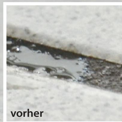
Gebrauchsfertige lösemittelfreie Spezial-Imprägnierung für alle saugfähigen zementären Fugenmaterialien. Vermindert dauerhaft das Eindringen oder Anhaften von Öl, Fett, Kalk, Wasser, färbenden Flüssigkeiten und allgemeinen Verschmutzungen. Das Produkt ist atmungsaktiv, unsichtbar und bildet keinen geschlossenen Film. Geeignet als Erstschutz oder zur nachträglichen Anwendung auf älterem Fugenmaterial.
